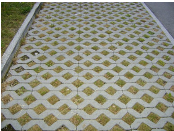
Bei diesem Rasengitterstein ist kleinwüchsige Vegetation erwünscht und das Regenwasser kann ungehindert versickern.
