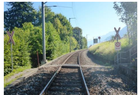
Bahnübergang Griesli km 17.647 wird aufgehoben und durch eine rückwärtige Erschliessung ersetzt.
